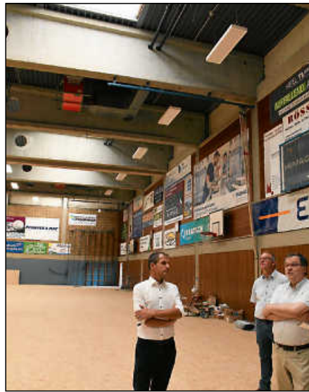
In der Schafhausackerhalle musste die abgehängte Hallendecke demontiert werden.
