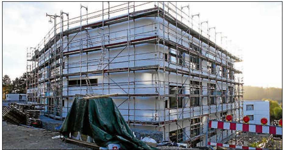
Plochingens seither größtes Bauprojekt die Gymnasiumbaustelle: Aufregend und spannend zugleich.
