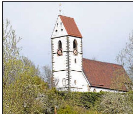
Die Sanierungsarbeiten in der Stadtkirche werden bis Mitte 2023 andauern.
