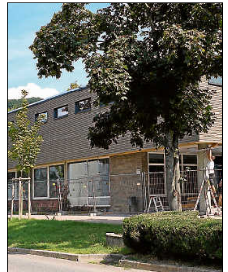
Die Fassade der Sporthalle in der Esslinger Straße wurde erneuert.
