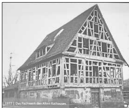
Das entkernte Alte Rathaus im Jahr 1977 vor seiner Versetzung an den Marktplatz.
