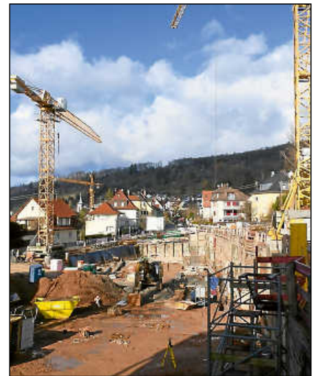
Am ehemaligen Moltke-Behälter sind die Bauarbeiten für eine Wohnbebauung im Gange.
