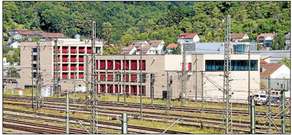
Bahnreisende haben sicherlich das neue Gesicht im Westen Plochings bereits entdeckt.
