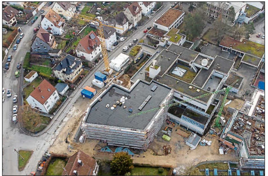
Die Vorteile sprechen dafür, erst eine Fotovoltaikanlage auf dem Dach des Neubaus (vorne) am Gymnasium zu installieren, bevor eine solche auf dem Realschuldach erstellt wird.
