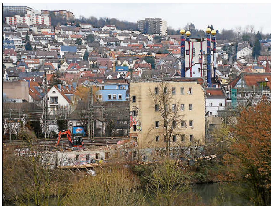
Nur noch Ruineteile des einstigen Stellwerks sind übrig. Ein genauer Zeitpunkt, wann der Abbruch beendet sein wird, steht noch nicht fest.
