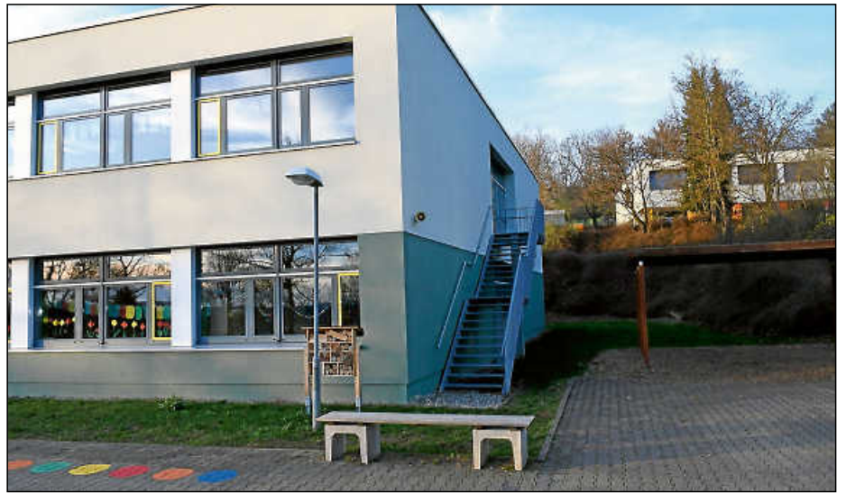
Zwischen Panorama- (l.) und Marquardtschule (r. oben) soll der Anbau entstehen.
