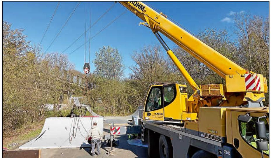
Auf einem Lkw mit Hänger wurde die Mini-Ramp in mehreren Betonbauteilen angeliefert und anschließend mittels eines Kranfahrzeugs an die richtige Stelle platziert.
