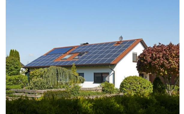
Dach (Süd, SW, SO...)
