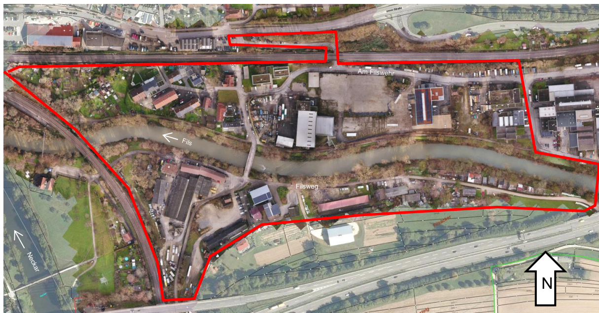
Abbildung 3: Luftbild des Plangebiets mit Fils (rot)
