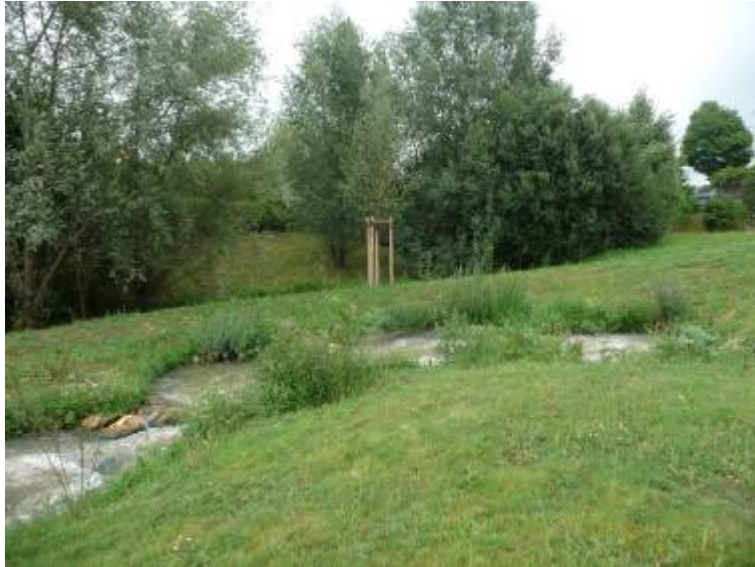
Fischtreppe unterer Teil
