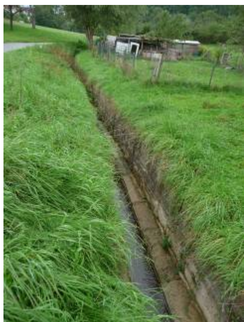
Stark verbauter Abschnitt des Hannestobelbaches
