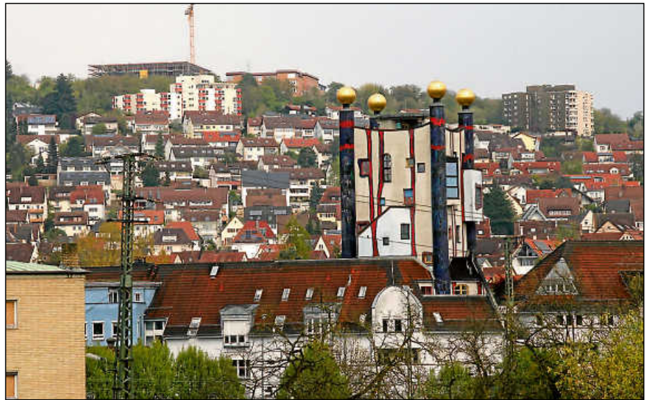
Angespannter Wohnungsmarkt: Wie in der gesamten Region Mittlerer Neckarraum herrscht auch in Plochingen Wohnungsnot.
