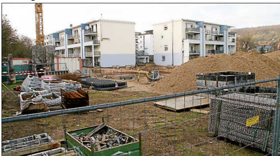
Das Gebäude „Neckarpunkt“ soll die Baulücke zwischen den zwei Bestandsgebäuden schließen.
