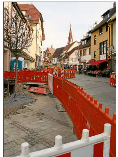
Nach anfänglichen Verzögerungen schreitet der Breitbandausbau in der Fußgängerzone nun voran.
