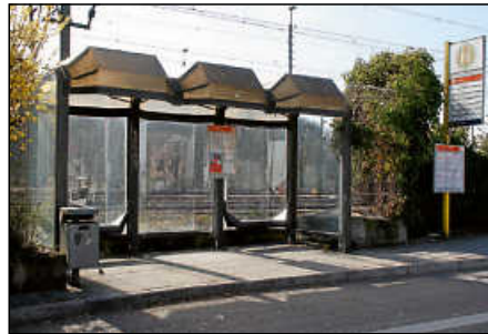
Das Haltestellenhäuschen wird erneuert, daher muss die Halte gesperrt werden.
