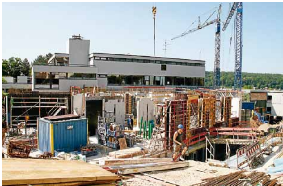
Die Rohbauarbeiten am Erweiterungsbau des Gymnasiums, die inzwischen fast abgeschlossen sind, kamen während des Sommers gut voran und liegen im Kostenrahmen.
