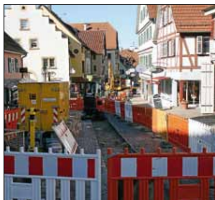
Auch in der Fußgängerzone wurden Breitbandkabel für schnelles Internet verlegt.
