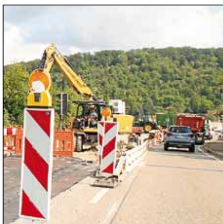
Die Brückensanierung wird voraussichtlich früher als geplant beendet werden können.
