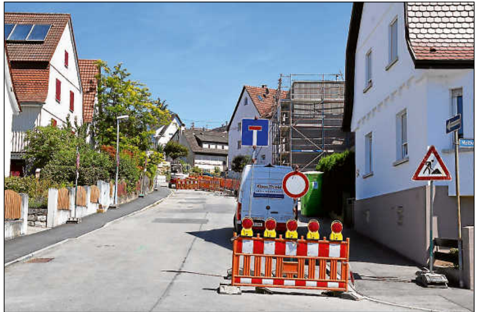
Das Bauvorhaben des Reha-Vereins (zweites Gebäude auf der rechten Seite) ist inzwischen weit fortgeschritten. Die obere Bergstraße ist in marodem Zustand, weshalb sie saniert, neu gegliedert und optisch aufgewertet werden soll.
