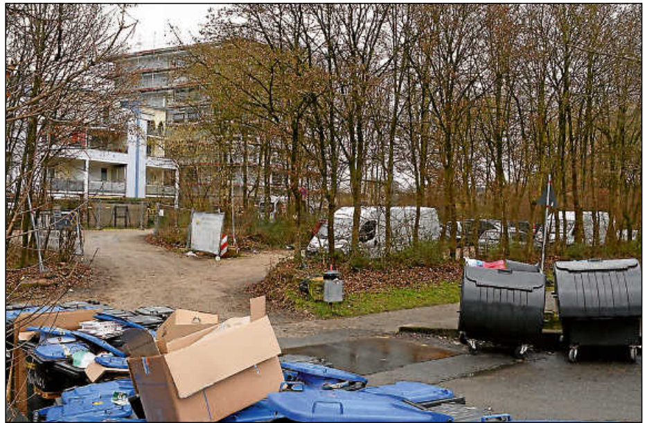
Noch in diesem Monat werden die Rodungsarbeiten für den Ausbau des Schotterparkplatzes am Bruckenbach beginnen. Auch das Problem mit den Müllbehältern wird gelöst.
