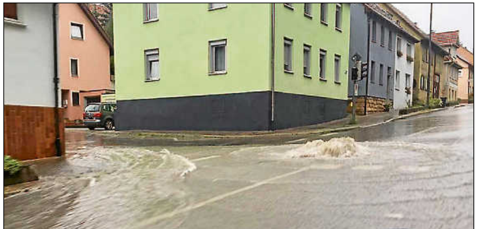
Aus einem Gullydeckel in der Schorndorfer Straße sprudelt nach einem Regenguß das Wasser.
