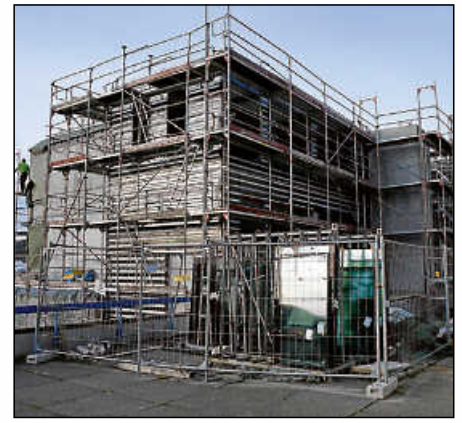
Der Kupferbau ist entkernt und die Technikerwerke haben ihre Arbeit aufgenommen.
