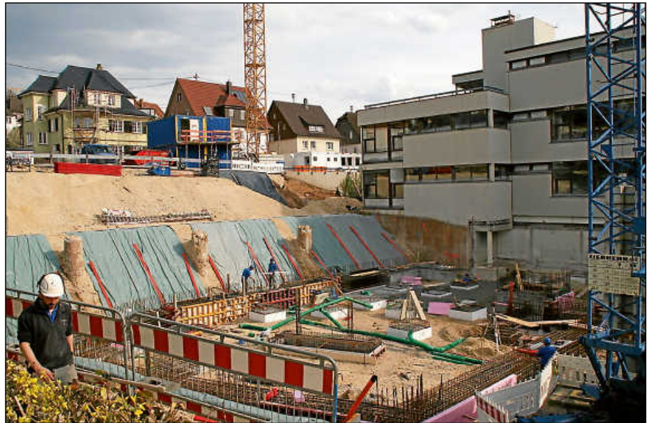
Emsiges Treiben auf der Baustelle: In dem neuen Anbau sollen die naturwissenschaftlichen Fachräume untergebracht werden. Außerdem soll ein Aufzug für Barrierefreiheit sorgen.
