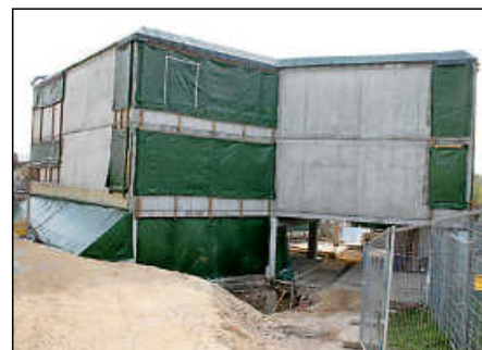
Der Kupferbau ist vollständig entkernt und bis auf den Rohbau zurückgebaut.
