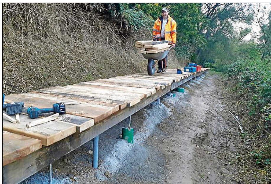
Nicht für die Ewigkeit, aber doch vielleicht für weitere Jahrzehnte: Durch das neue Fundament und die Eichenbalken wurde der Filsuferweg aufgewertet.
