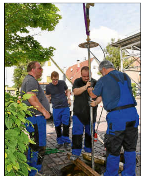
Wassermeister Marcel Reith (2. v. r.) justiert das letzte Rohr mit dem Anschluss zur Leitung.
