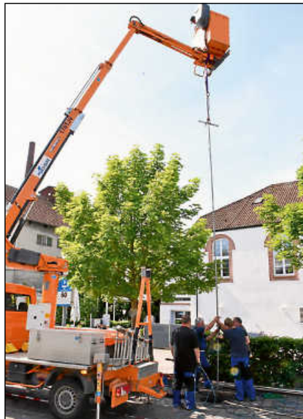
Mit dem Kran werden die langen Rohre ausgerichtet und anschließend verschraubt.
