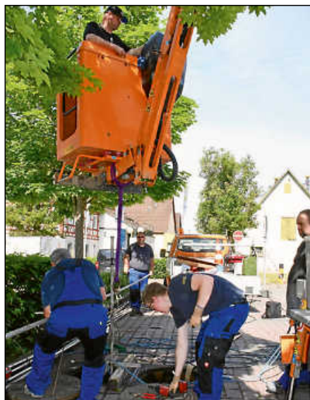
Stück für Stück werden die Rohre im Schacht zum Grund der Quelle geschoben.
