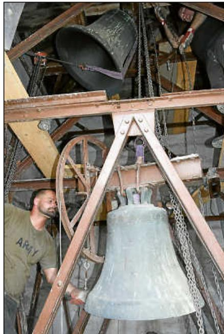
Die Glocken wurden jüngst abgehängt. Ein Glockenstuhl aus Holz soll eingebaut werden.
