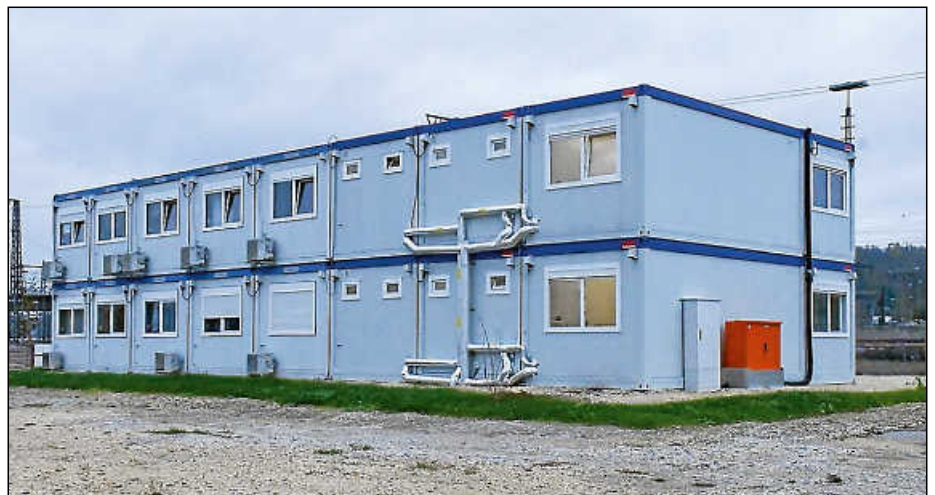
Die Containeranlage für Flüchtlinge in der Eisenbahnstraße soll ein weiteres Geschoss erhalten.
