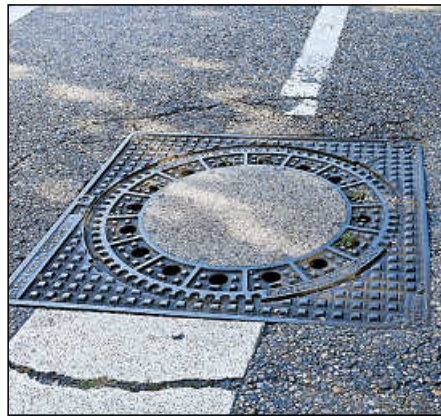
Ein Straßenschacht vorher ...
