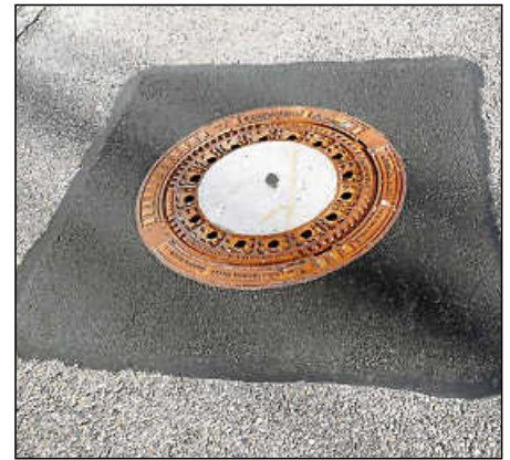
... und ein anderer nach der Sanierung.
