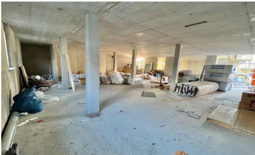
Blick in die zukünftigen Praxisräume
