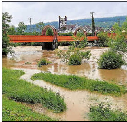
Wassermassen überfluteten das Neckarvorland.
