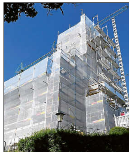
St. Konrad wurde eingerüstet und verpackt.
