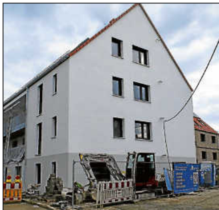
Das „Brühl-Areal“ wurde fertiggestellt.
