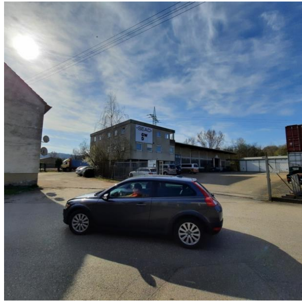
Abb. 10: Gebäudekomplex an der Ruderalfläche, der u.a. von Haussperling ( Passer domesticus ) und Star ( Sturnus vulgaris ) zur Brut genutzt wird.
