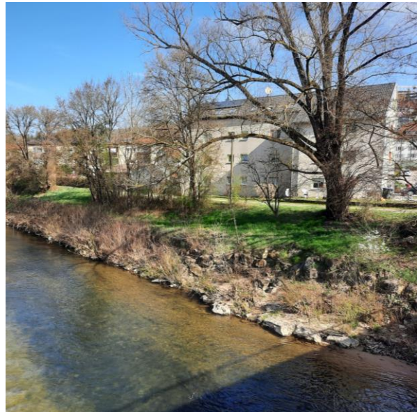
Abb. 9: Umfeld der bestehenden Brücke an der Fils. Blick auf die südwestliche Grenze des Vorhabensbereichs.
