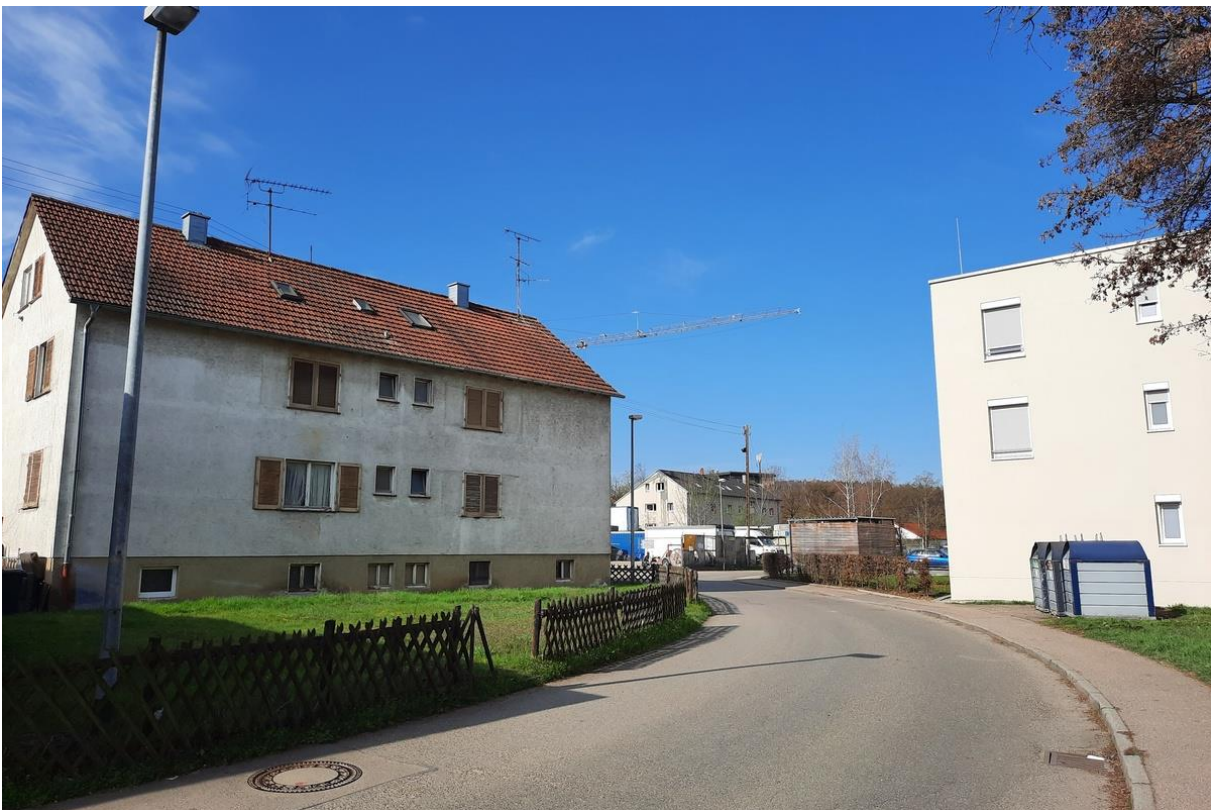
Abb. 3: Im Untersuchungsgebiet finden sich sowohl ältere Wohnhäuser mit erkennbaren Schäden als auch Neubauten. Insbesondere ältere Gebäude wie hier links im Bild bieten für gebäudebrütende Vogelarten und mehreren Fledermausarten eine Vielzahl an Nist- bzw. Quartiermöglichkeiten.
