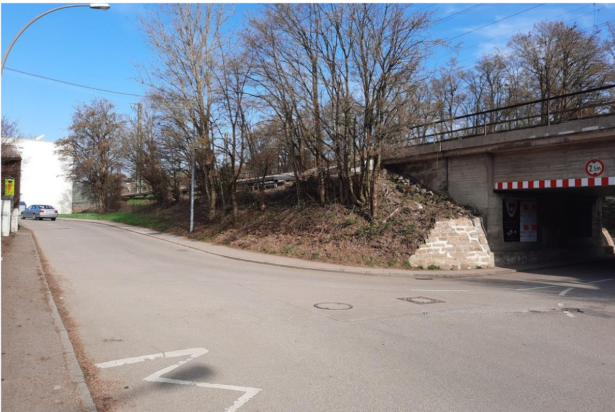
Abb. 6: Im nördlichen Teil des Vorhabensbereichs verläuft eine Bahntrasse. Die begleitenden, teilweise südexponierte Böschungen bieten gute Habitatbedingungen für geschützte Reptilienarten wie die Mauereidechse ( Podarcis muralis ).
