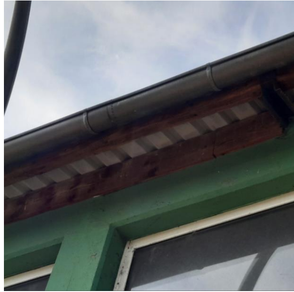
Abb. 5: Nischen an diesem gewerblich genutzten Gebäude können als Brutplatz für Vögel oder als Quartier für Fledermäuse dienen.
